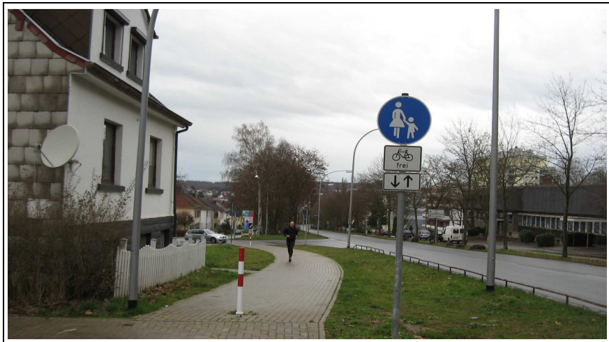
Bild 6-9: Gehweg mit zugelassenem Radverkehr für Zweirichtungsradsverkehr; Pfosten als Hindernis (B 251, Saarbrücken)
