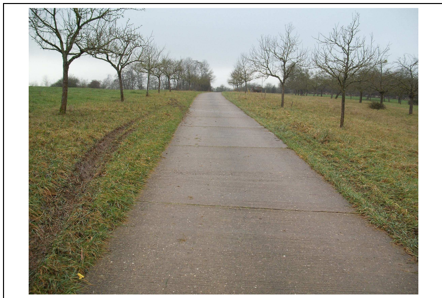
Bild 3-10: Niedtal-Radweg auf betonierte[m]m landwirtschaftliche[m]m Weg (Gemeinde Rehlingen-Siersburg)
