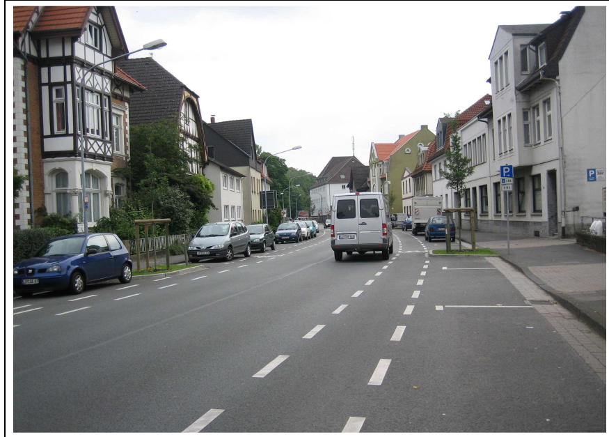
Bild 6-29: Schutzstreifen mit Sicherheitsraum zu parkenden Kfz in einer Ortseinfahrt
