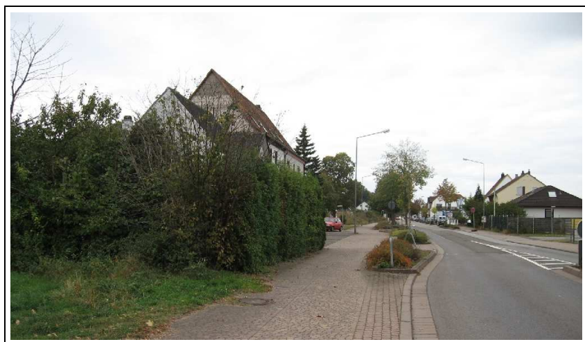
Bild 5-3: Straßenbegleitender gemeinsamer Geh- und Radweg (L 119, Homburg)
