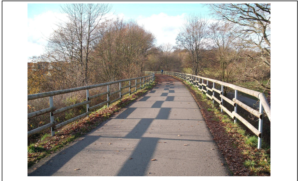
Bild 3-11: Wendelinus-Radweg auf ehemaliger Bahntrasse (Gemeinde Oberthal)
