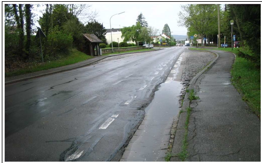
Bild 6-19: Zu schmaler Schutzstreifen mit schlecht nutzbarer Rinne (L 173, Merzig/Hilbringen)
