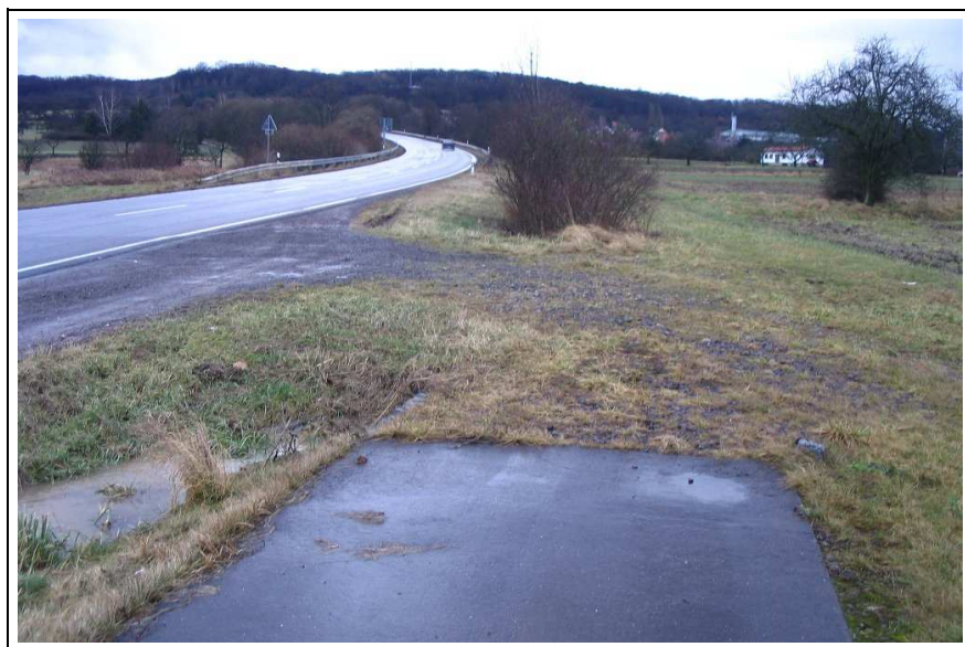
Bild 6-22: Abruptes Radwegende (L 254, Kleinblittersdorf)
