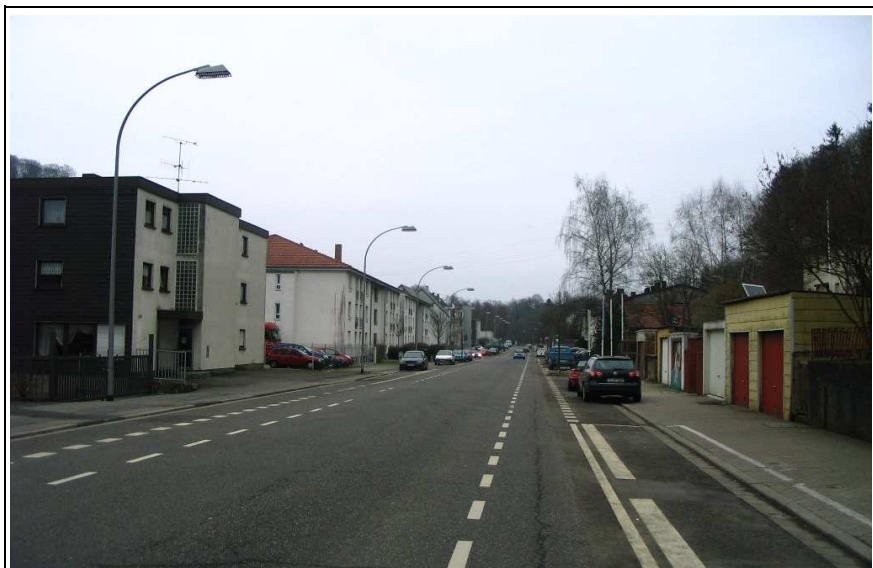
Bild 6-10: Beidseitiger Schutzstreifen in einer Ortsdurchfahrt (B 40, Saarbrücken/Scheidt)
