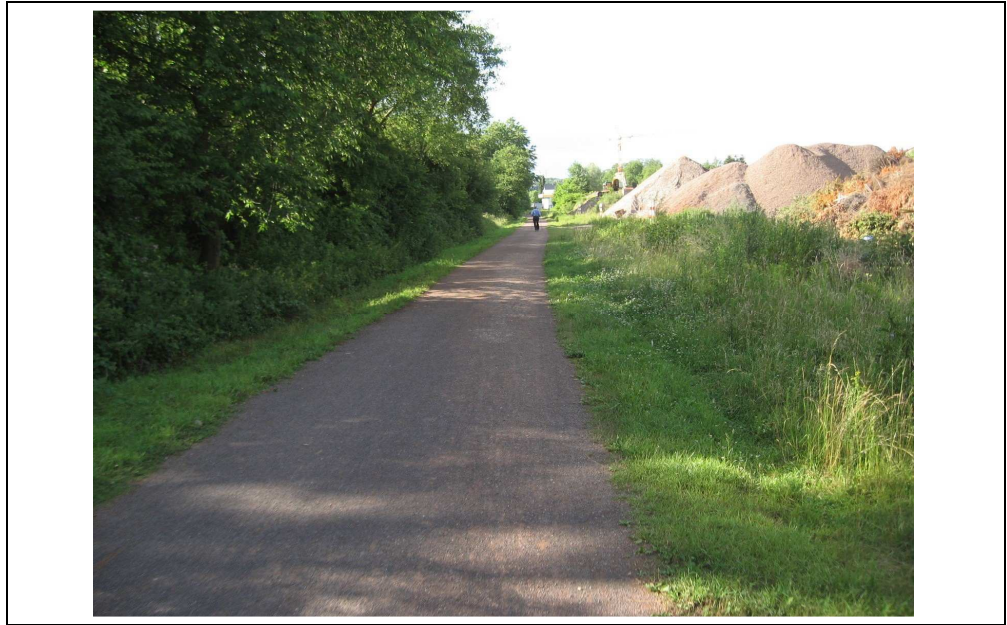
Bild 3-7: Köllertal-Radweg (Gemeinde Püttlingen)
